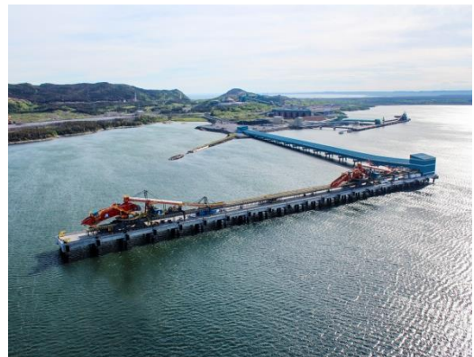
Nouveau quai de minerai de fer multi-utilisateurs à Sept-Îles, QC
